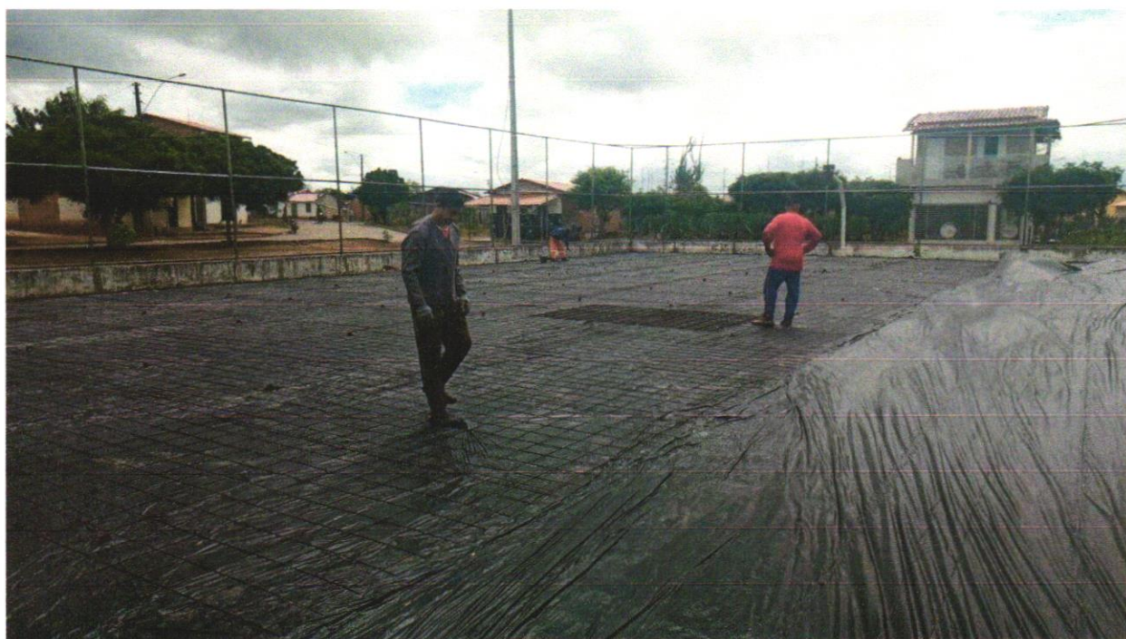
Foto 03- APLICAÇÃO DE LONA PLÁSTICA PARA EXECUÇÃO DE PAVIMENTOS DE CONCRETO. AF_11/2017
