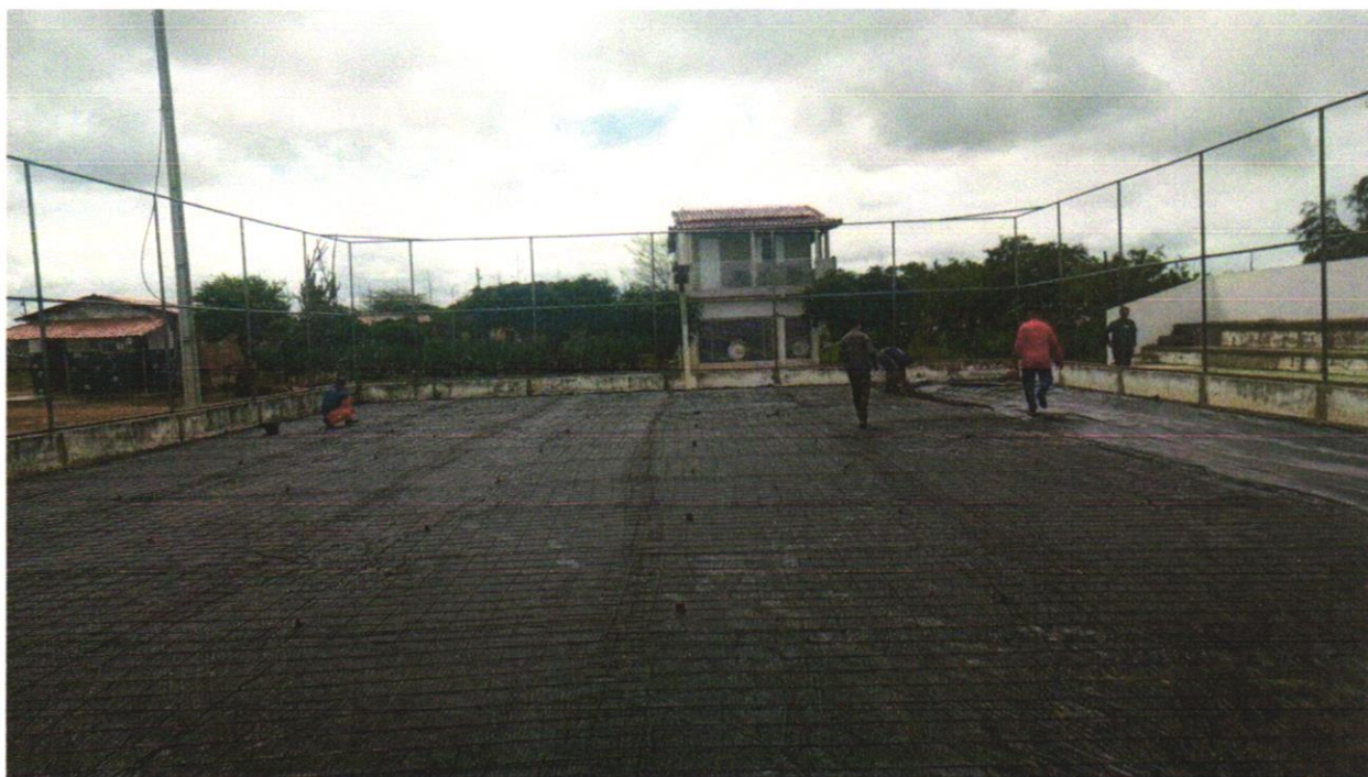
Foto 05 - FORNECIMENTO E INSTALAÇÃO DE TELA AÇO SOLDADA NERVURADA CA-60, MALHA 15X15CM, FERRO 4.2MM, PAINEL 2X3M, (1,50KG/M 2 ), MALHA POP REFORÇADA GERDAU OU SIMILAR
