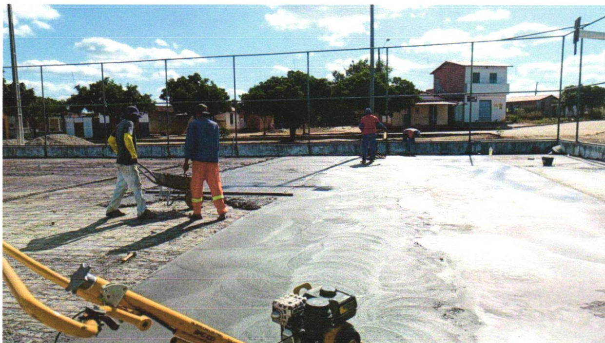
Foto 09- ACABAMENTO POLIDO PARA PISO DE CONCRETO ARMADO DE ALTA RESISTÊNCIA. AF_09/2017
